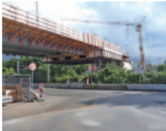
Eine der Brücken der Westumgehung
